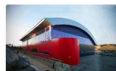
PABELLÓN MUNICIPAL DE VIATOR (VIATOR)
