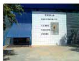
PABELLÓN VÍCTOR CABEDO - PISTA CENTRAL (ONDA)
